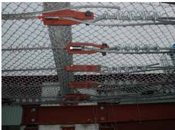
写真 7 緩衝金具の取付け
