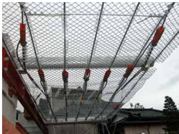
写真 7 緩衝金具の取付け
